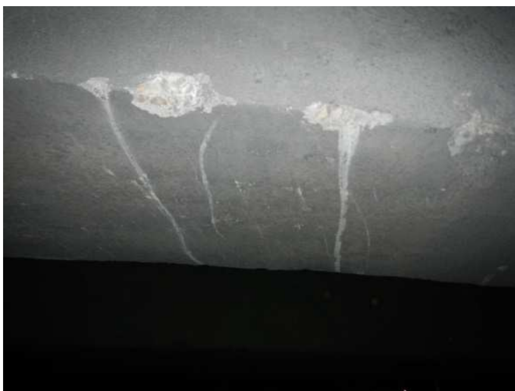
Photo 28 : Frottements et épaufrures sur poutre de rive Nord sens Bordeaux
