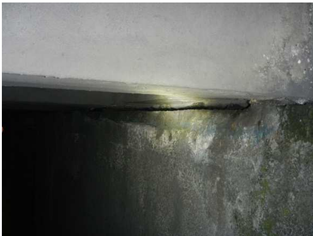
Photo 31 : Morceau de béton absent sur P1
