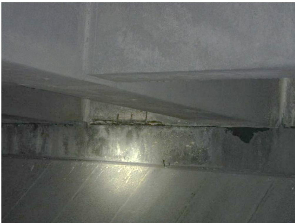
Photo 29 : AA sur poutre sur culée C0 (Est)
