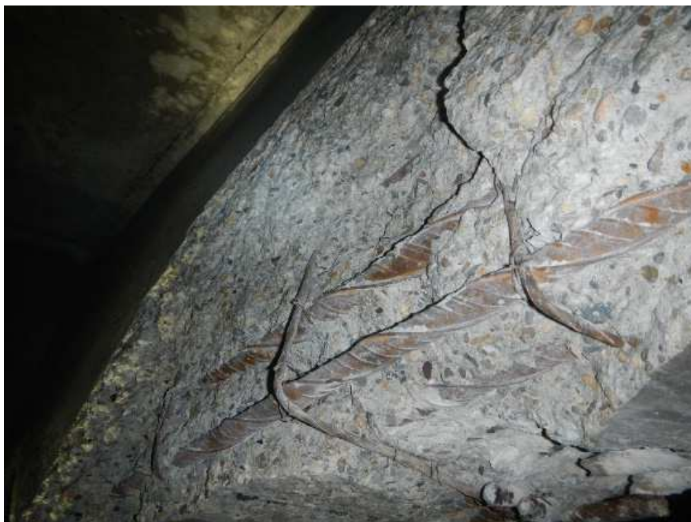
Photo 23 : Armature à nue sur poutre de rive Sud sens Paris
