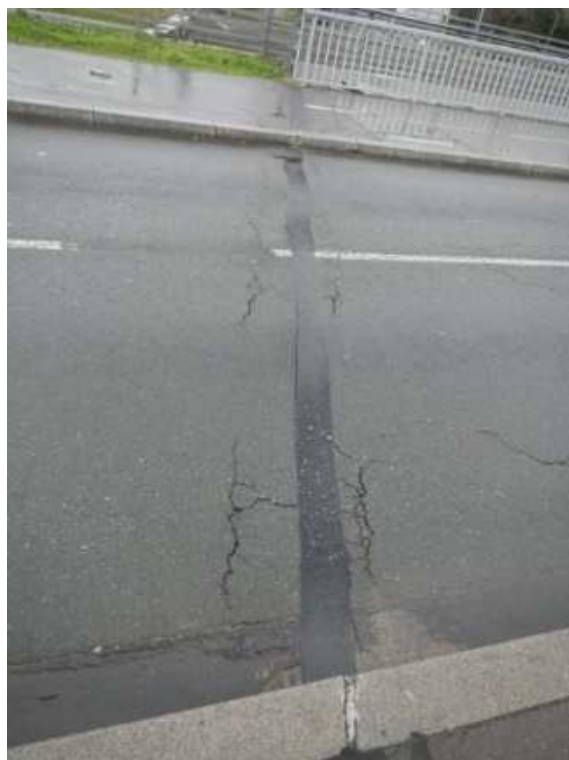
Photo 7 : Joint de chaussée Ouest (C4)
