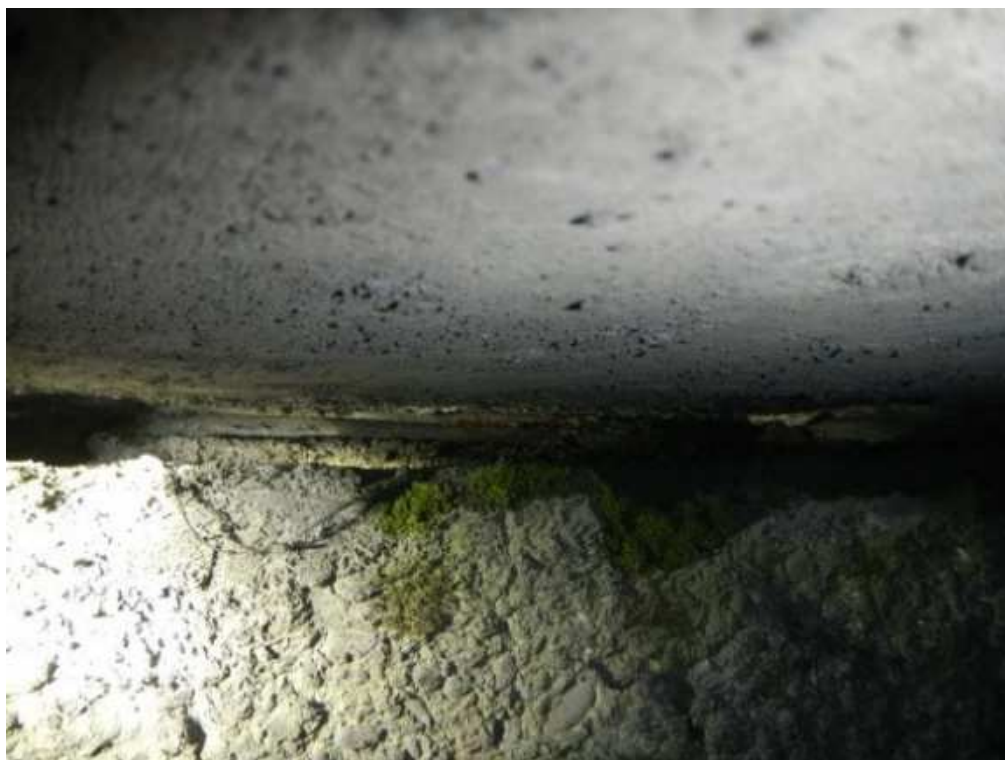
Photo 19 : Appareil d'appui sur P3
