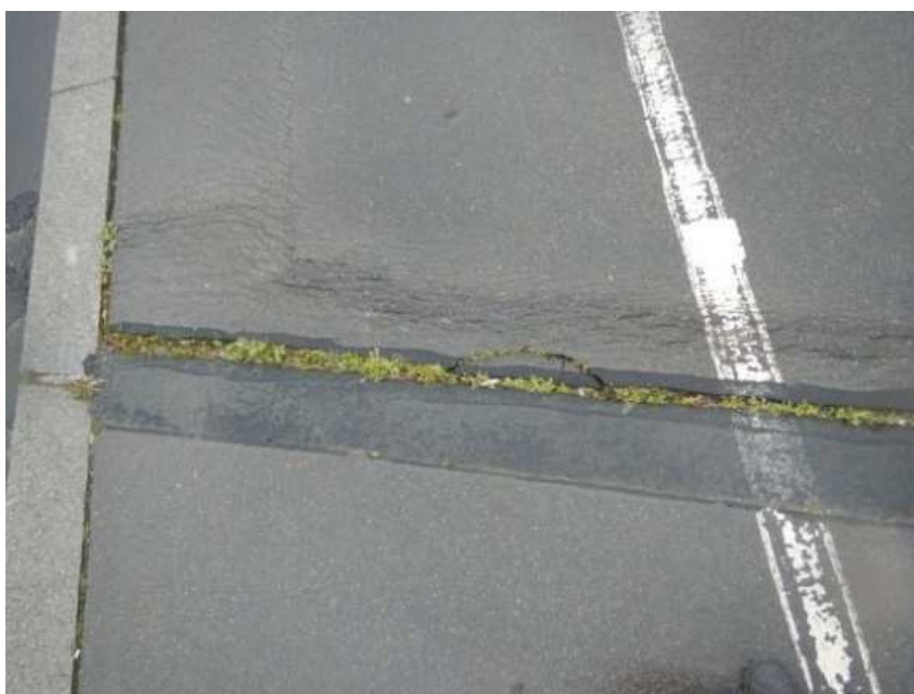
Photo 14 : Joint de trottoir Est (C0)
