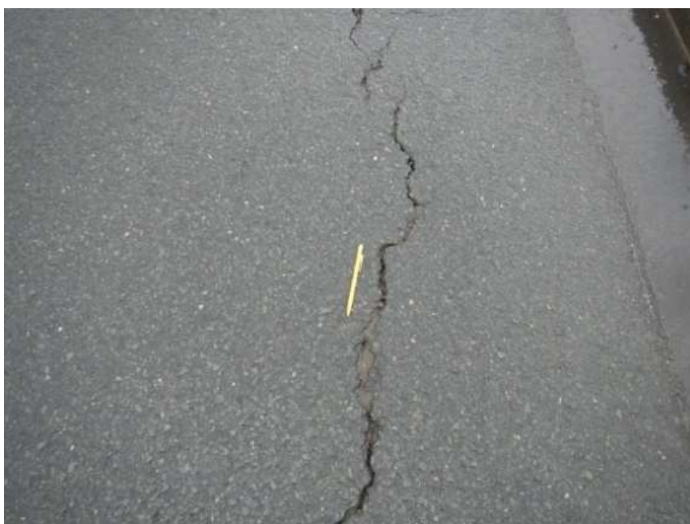
Photo 16 : Fissure sur chaussée
