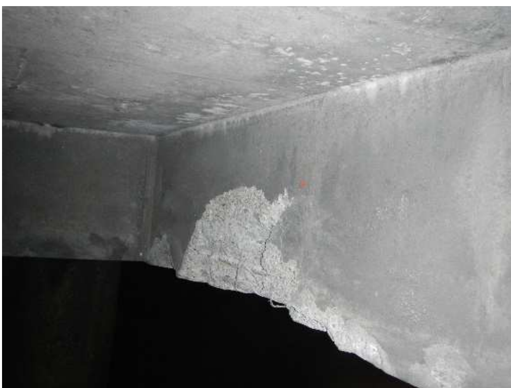
Photo 26 : Armature à nue sur poutre de rive Sud sens Paris
