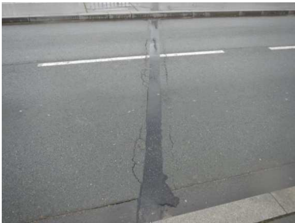
Photo 13 : Joint de chaussée P1
