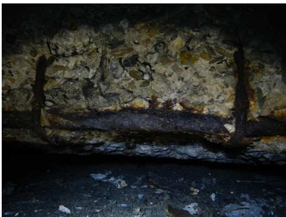
Photo 22 : Armature à nue sur poutre de rive Sud sens Paris
