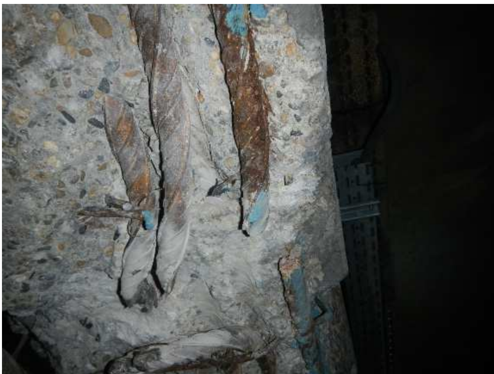
Photo 25 : Armature coupée sur poutre de rive Sud sens Paris
