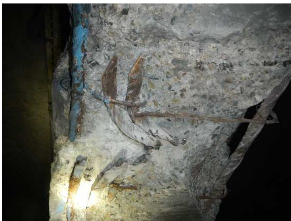
Photo 24 : Armature coupée sur poutre de rive Sud sens Paris
