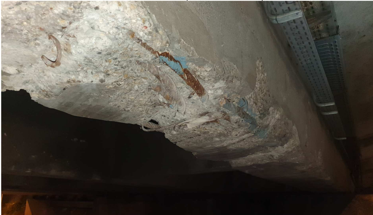
Photo 1 – Poutre de couronnement endommagée
