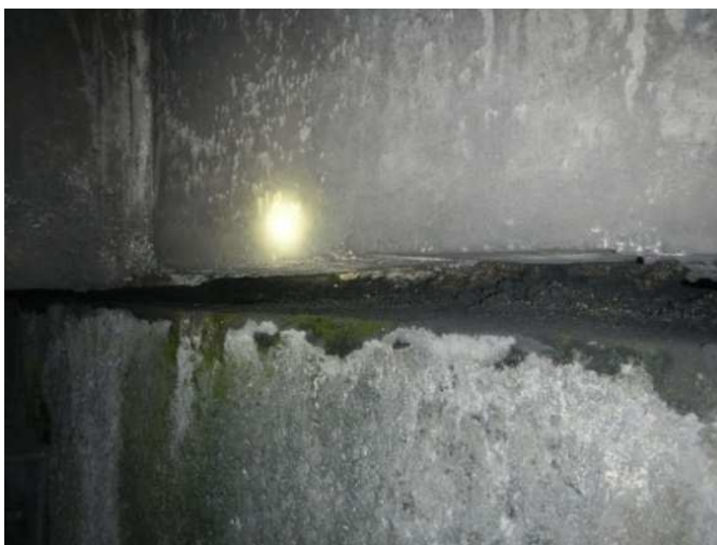
Photo 20 : Appareil d'appui sur P2
